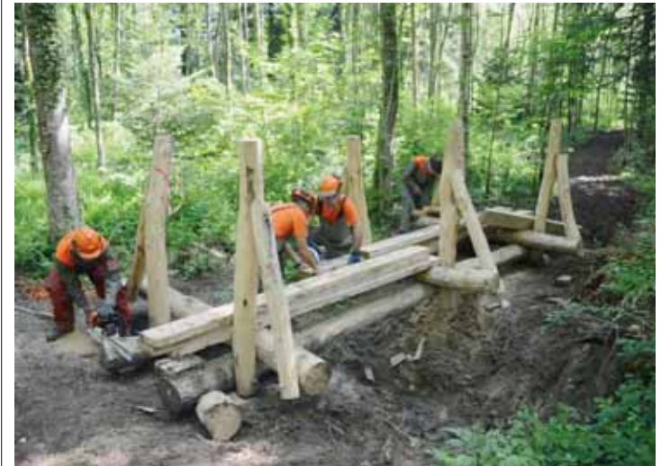
Les ouvriers travaillent d'arrache-pied pour achever les infrastructures situées le long du sentier, au bois d'Engollon. ARCHIVES CHRISTIAN GALLEY
